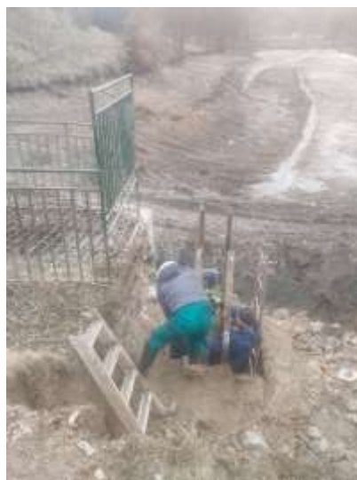
Demolice části stavidla rybníka ↑
