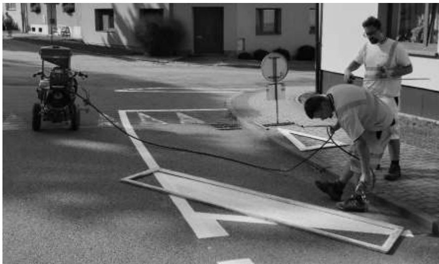
Nástřik vozovky v ulici Pod Školou
